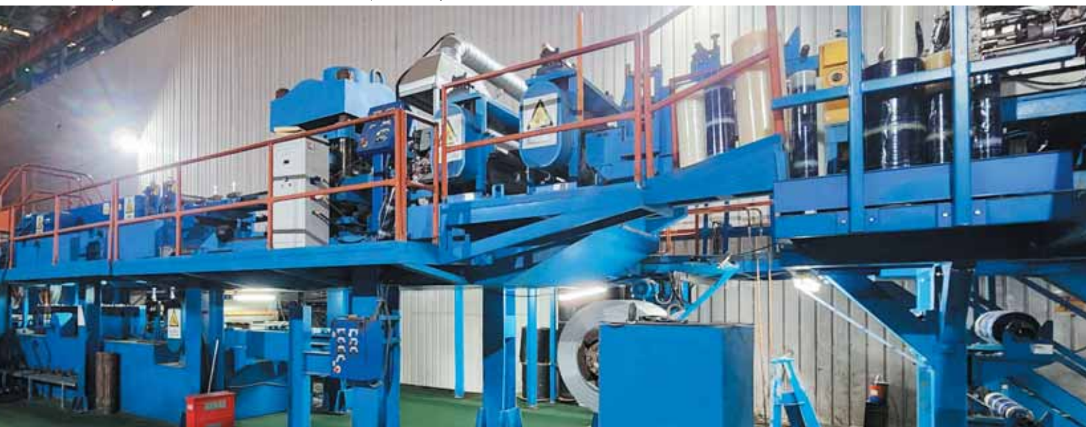
Завод воротных систем, автоматическая линия по производству сэндвич-панелей
