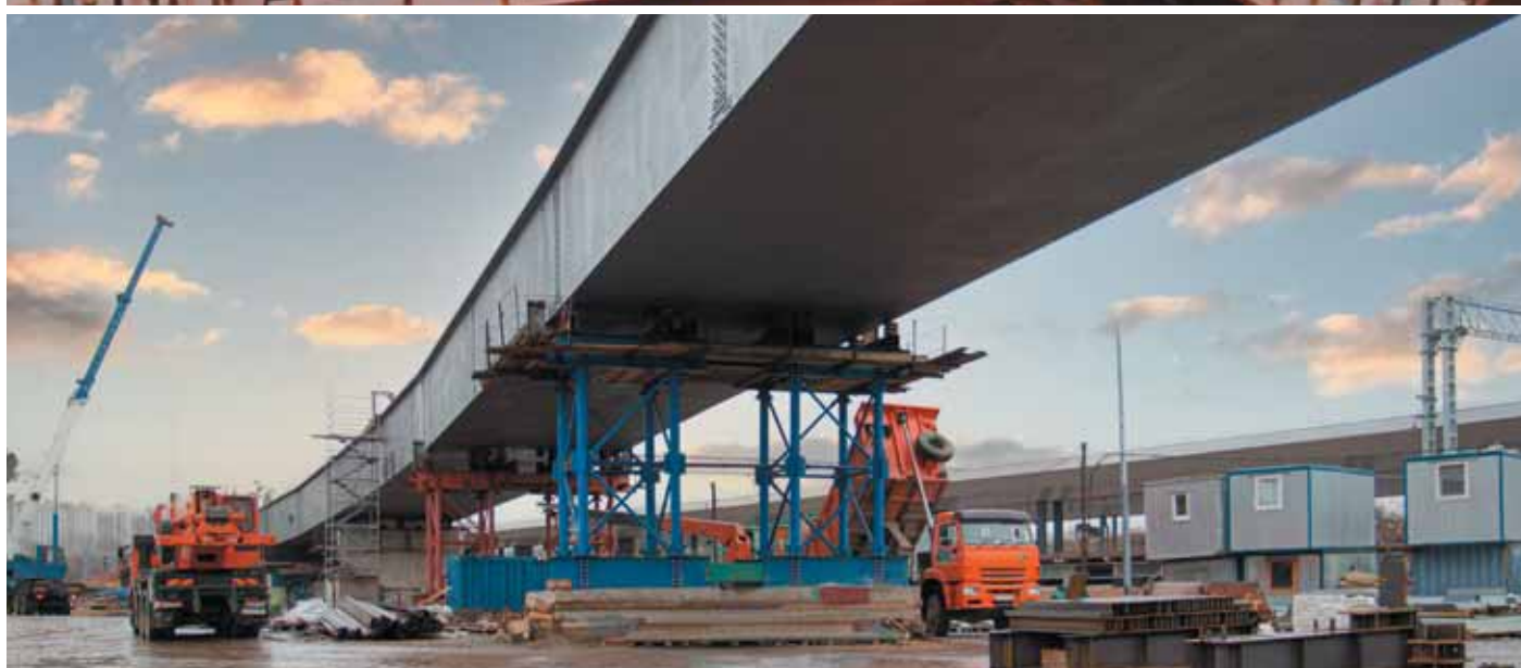
РОССИЯ, МОСКВА. Строительство мостовых конструкций, участок от ул. Шоссейной до ул. Полбина
