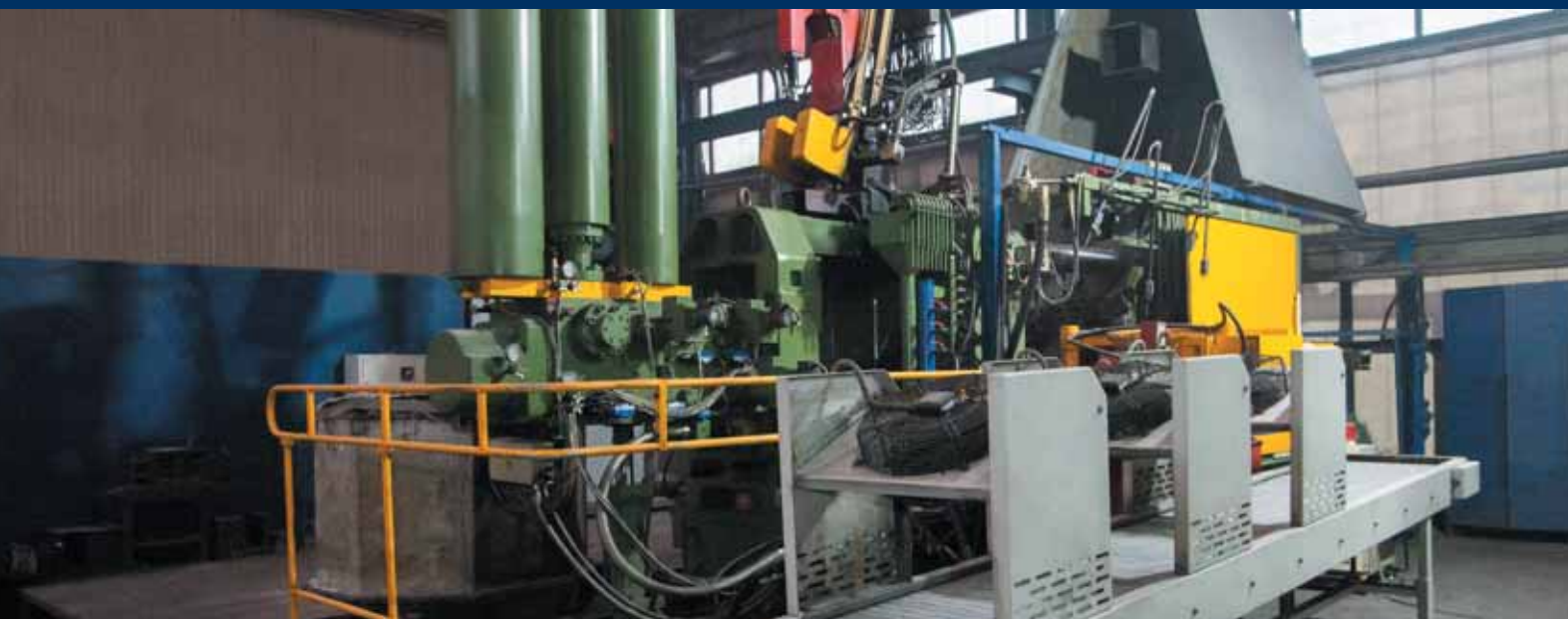
Завод систем автоматизации, цех литья под давлением
