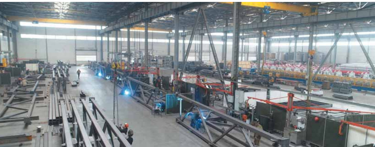
Завод полнокomплектных зданий, сборо-сварочный цех
