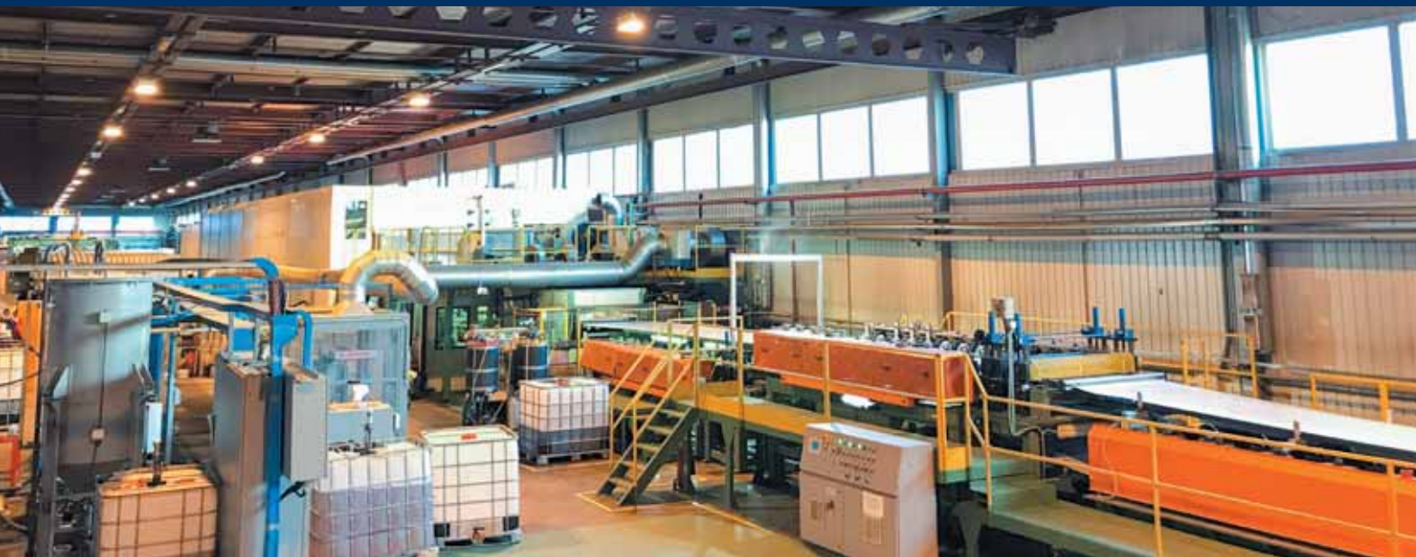
Цех производства PIR-панелей, пресс с термостатированием
