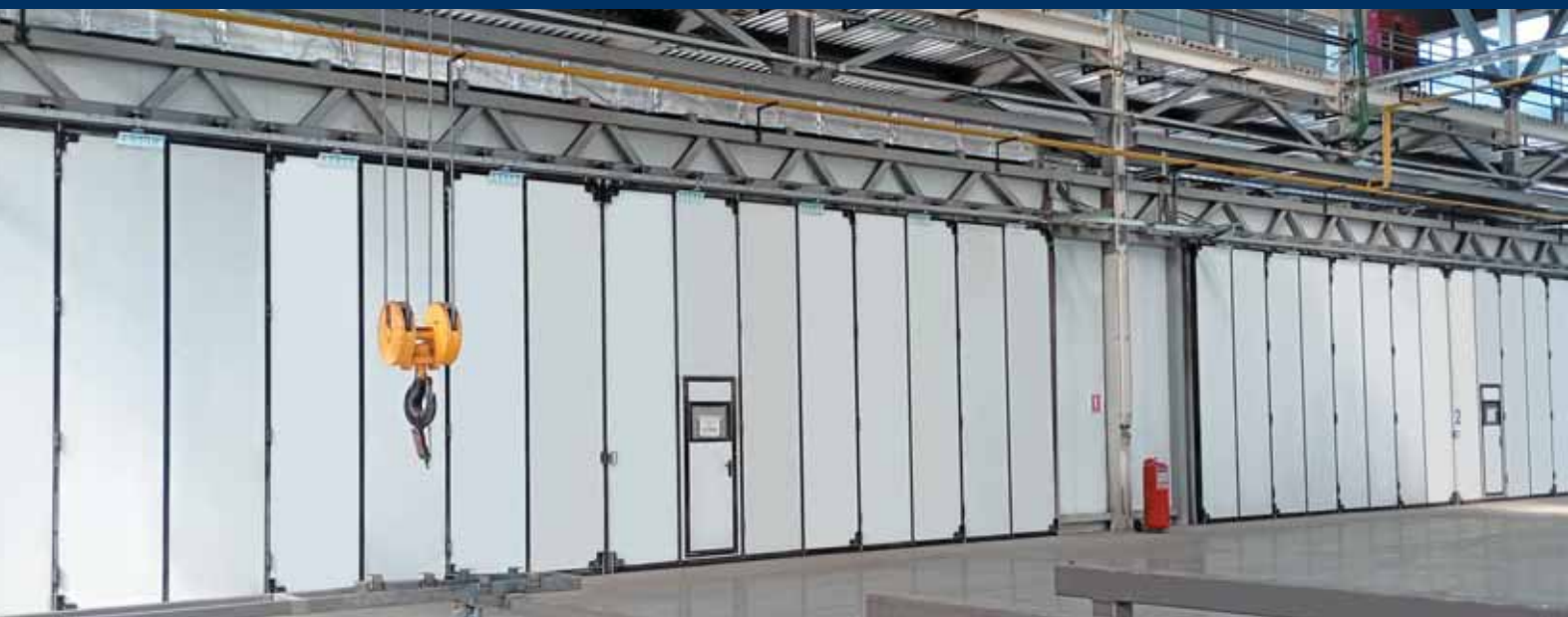
Завод полнocomплектных зданий, покрасочная камера
