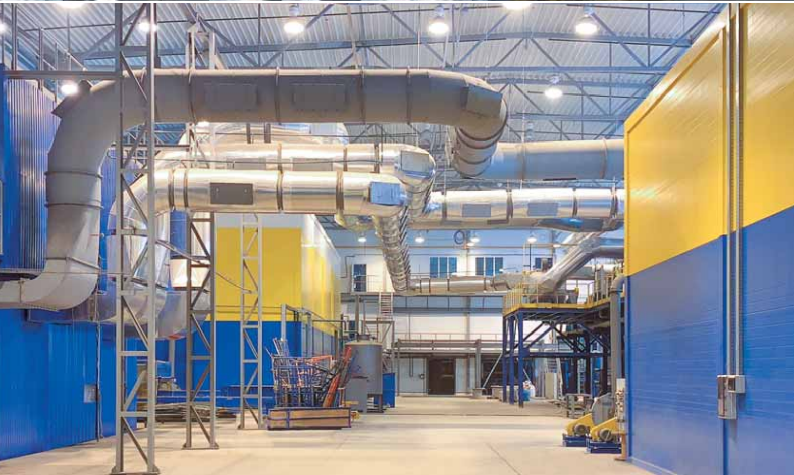
Завод минераловатных плит, цех по производству минераловатных плит
