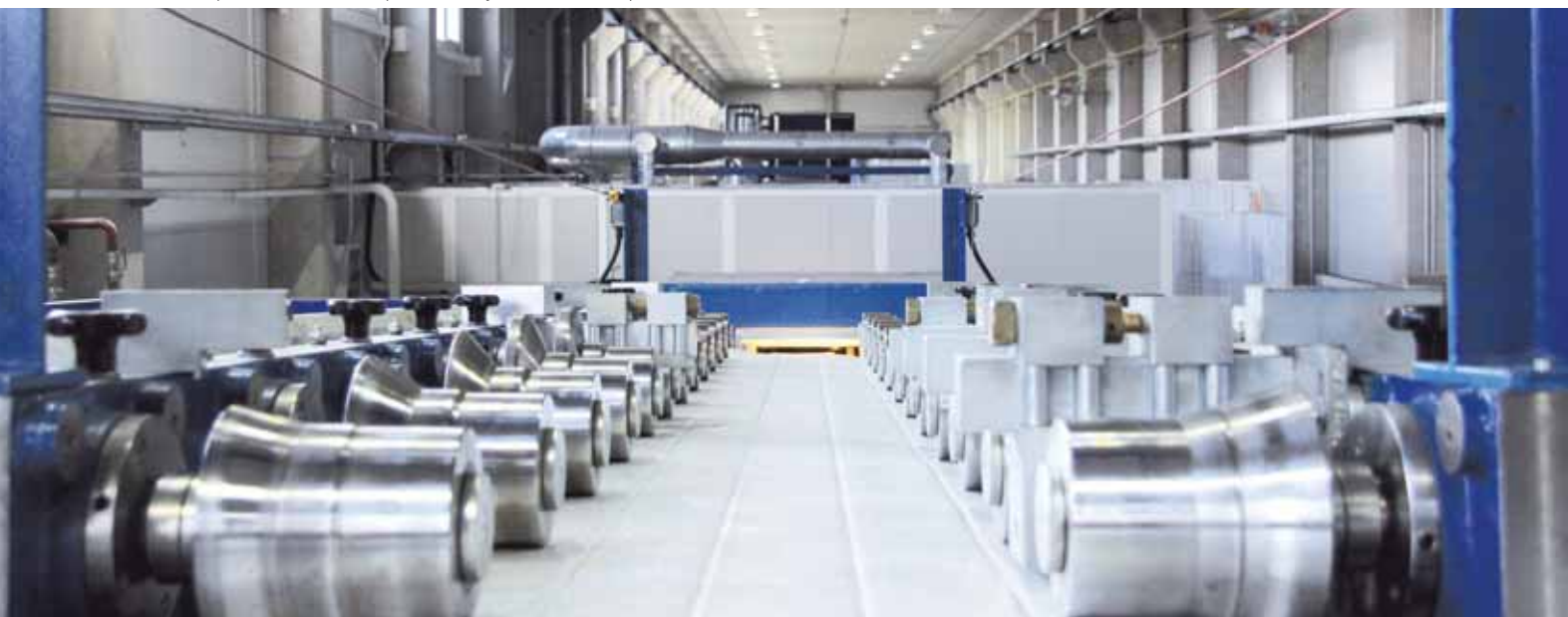
Линия по производству сэндвич-панелей, секция профилирования
