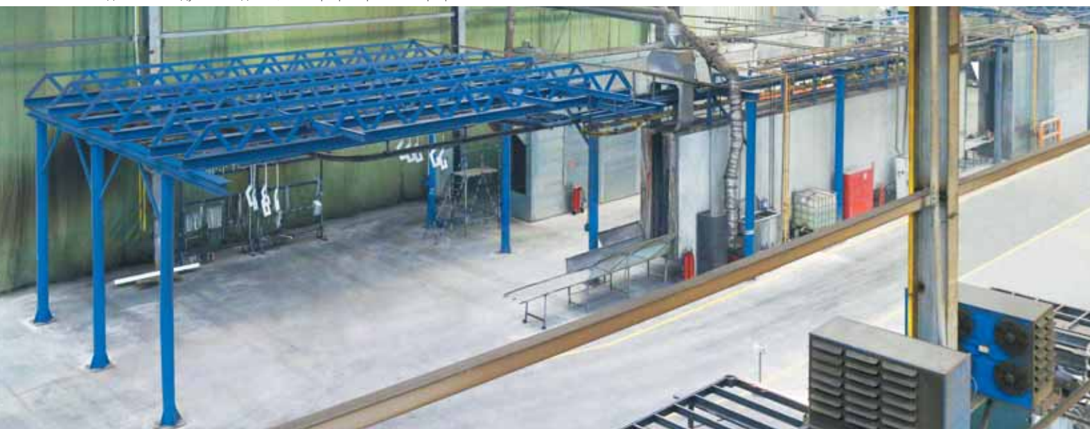
Завод блочно-модульных зданий, цех порошковой окраски
