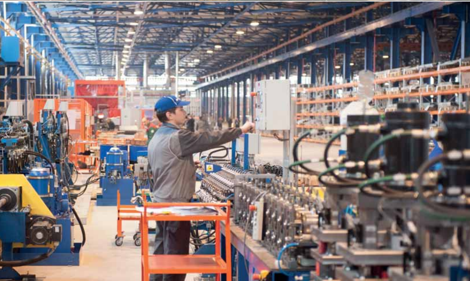
Завод дверных систем, цех производства дверных рам, линия прокатки дверного профиля
