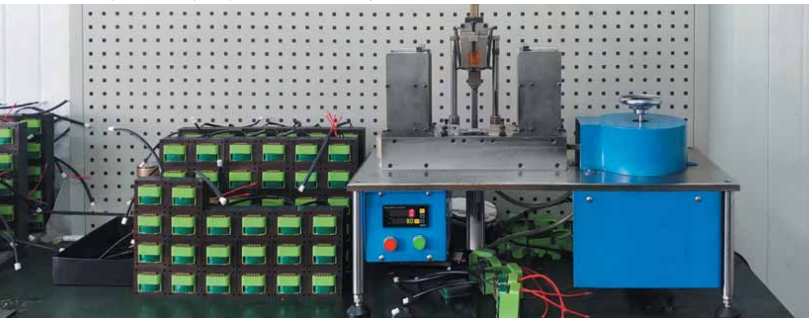
Завод электромеханики и микроэлектроники, цех производства трансформаторов
