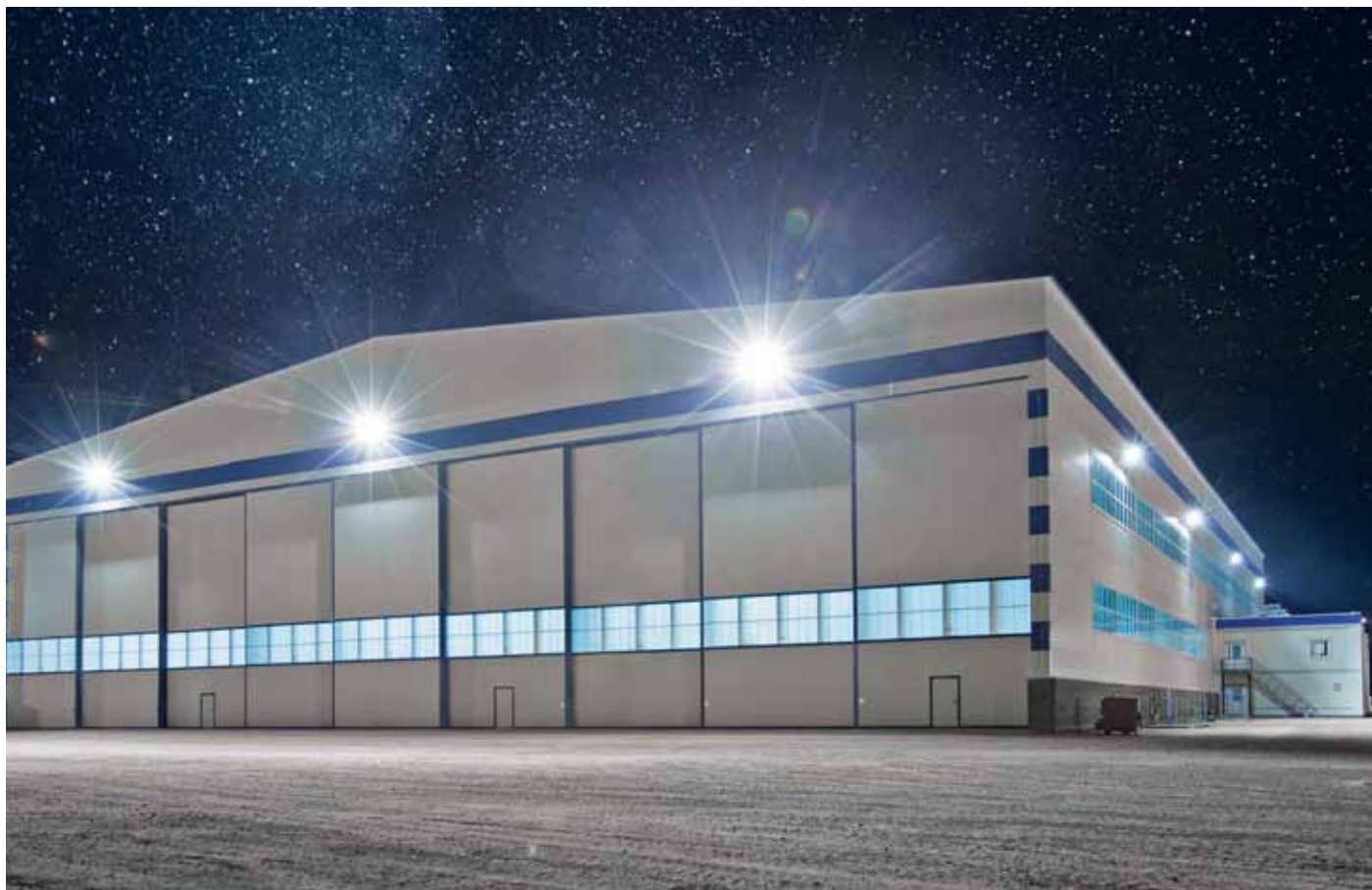
КАЗАХСТАН, АКТАУ. Производственный корпус, ворота 72 × 15 м
