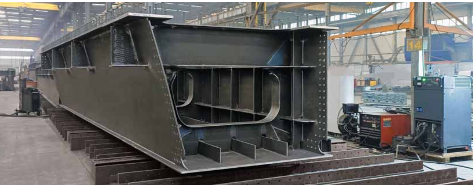
Завод мостовых конструкций, сборо-сварочный цех
