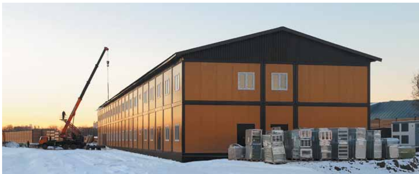
РОССИЯ, МОСКВА. Стройплощадка
