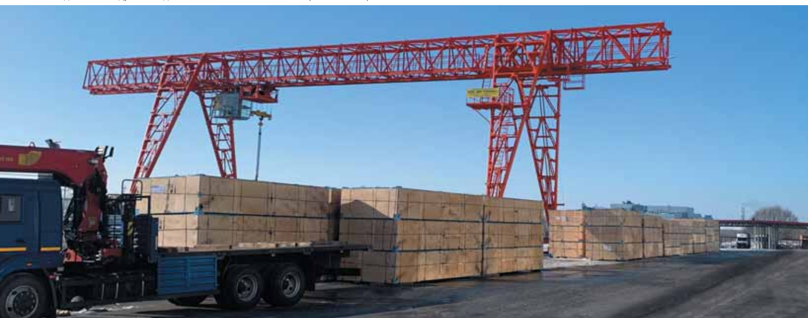
Завод блочно-модульных зданий, склад готовой продукции
