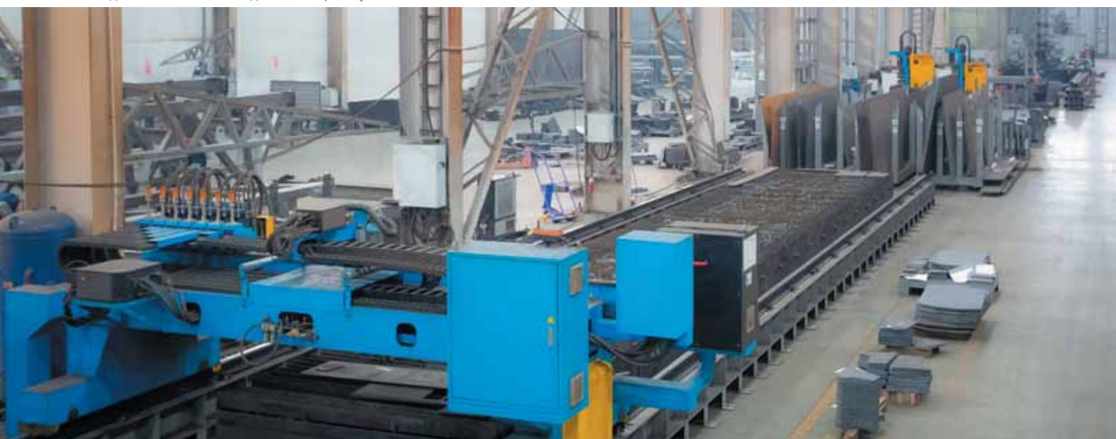
Завод полнокomплектных зданий, линия автоматической плазменной резки
