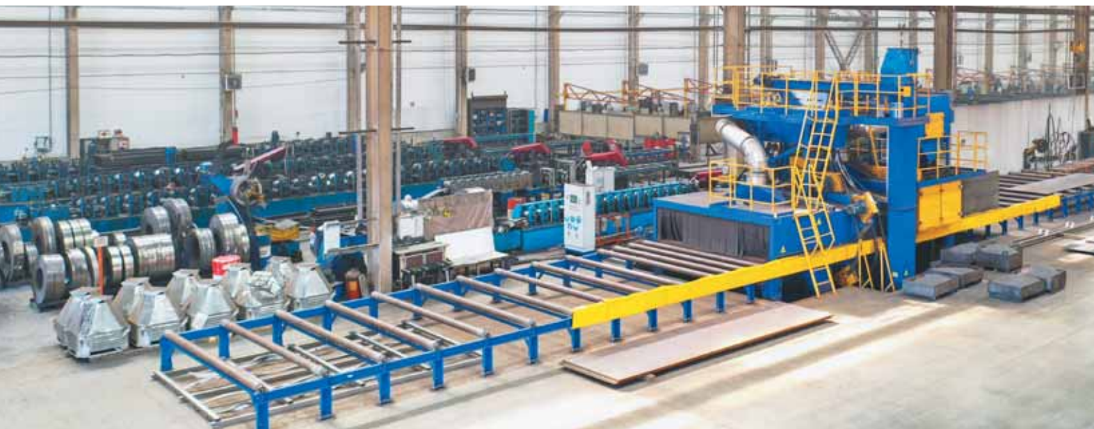
Завод полнокомплектных зданий, заготовительный цех
