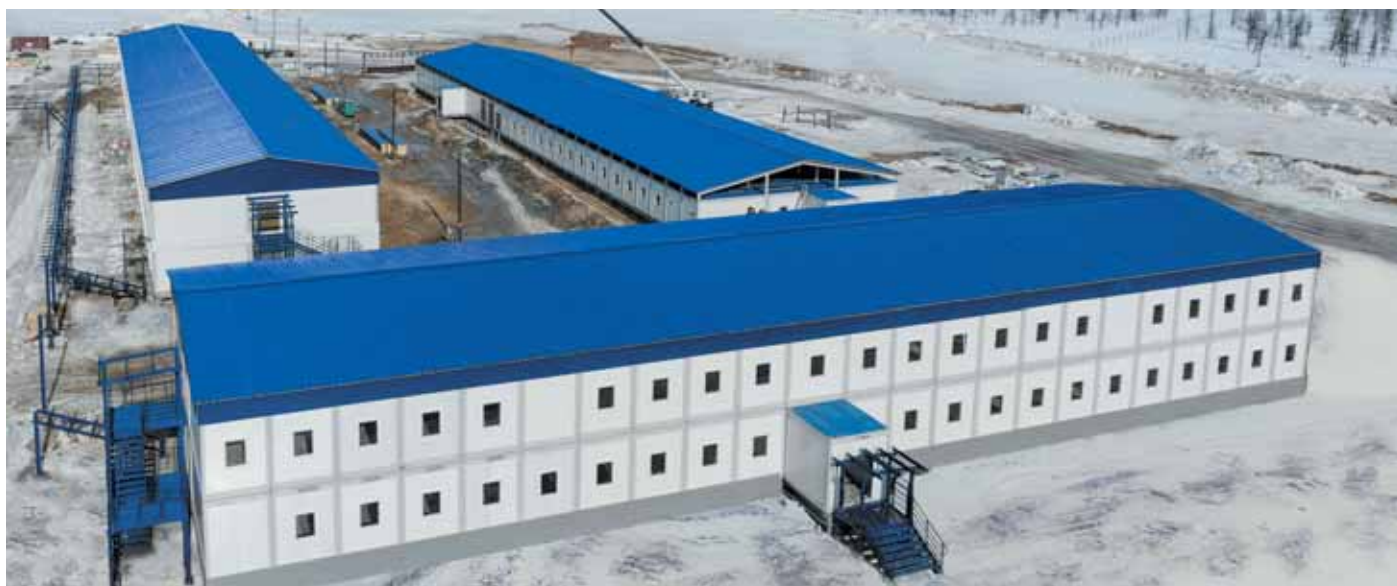
РОССИЯ, ЯМАЛО-НЕНЕЦКИЙ АО. Строительство вахтового поселка
