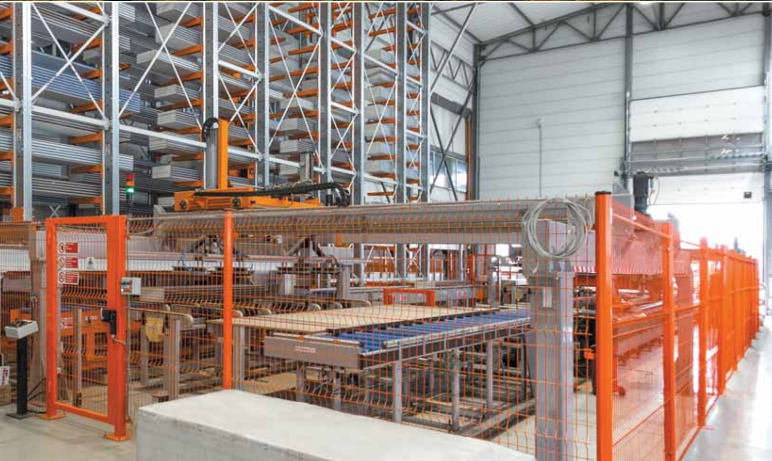
Завод воротных систем, автоматизированный склад и обрабатывающий центр
