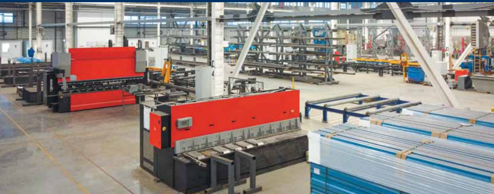
Завод блочно-модульных зданий, гидравлические гильотинные листовые ножницы, гидравлический листогибочный пресс
