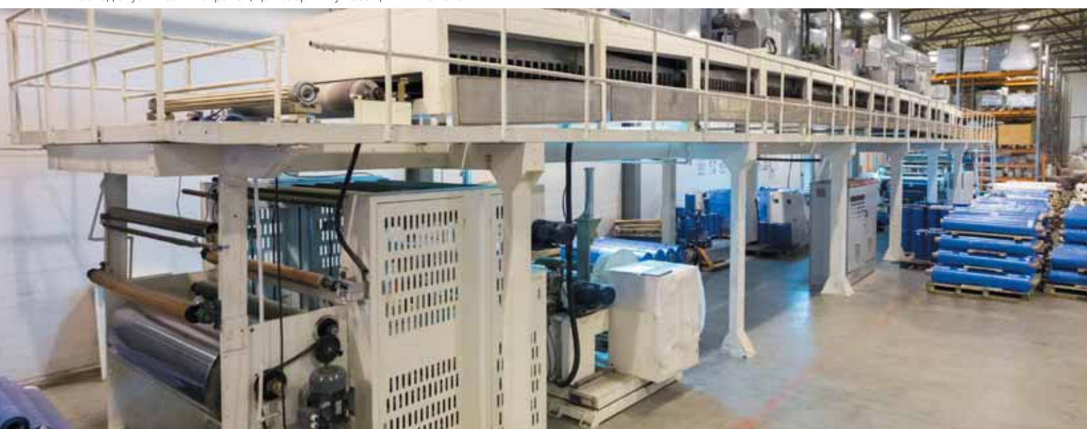
Завод акустических экранов, автоматическая линия производства ЛЗК-пленки
