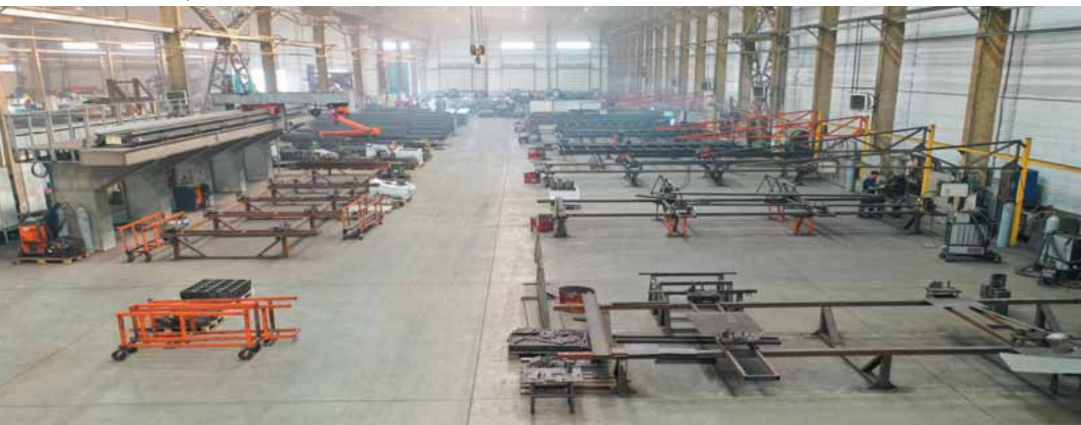
Завод блочно-модульных зданий, роботизированный цех
